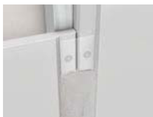
Traitement de joint (Plaques à bords amincis)
